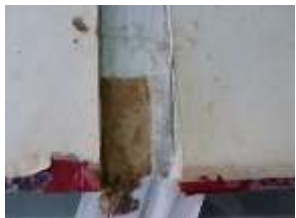
Refuerzo de lomo desgarrado.
