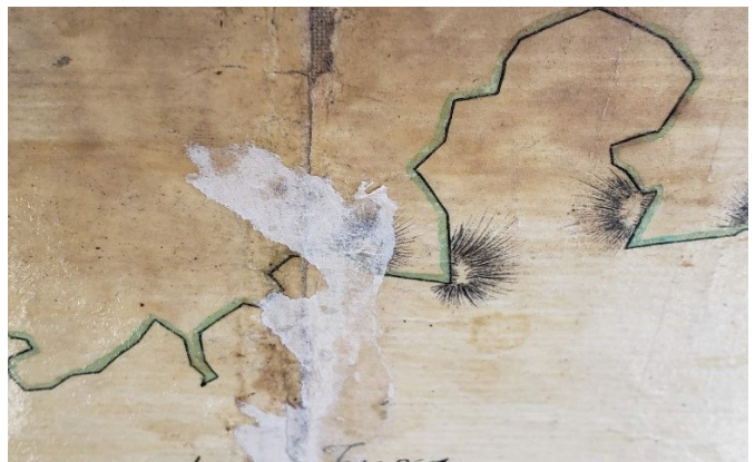
Foto 3. Detalle que muestra intervenciones anteriores para corregir faltantes y parte de la zona superior afectada por biodeterioro.
