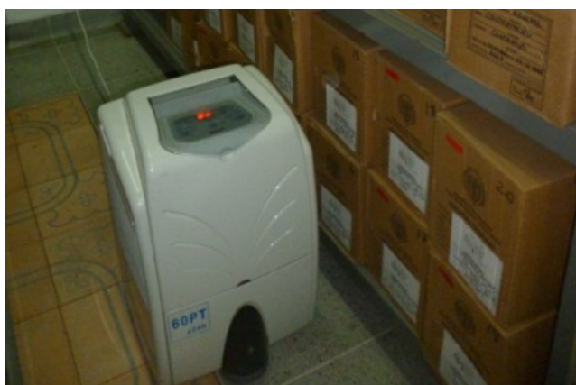
Equipo deshumidificar instalado al interior de un depósito de archivo.
